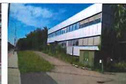
Oude kantoorgebouwen Bekaert
